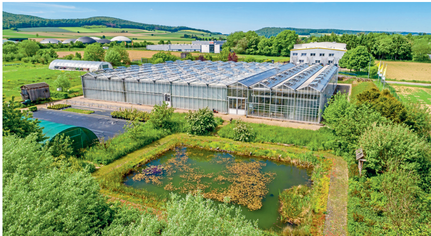
Blick auf die Versuchsgärtnerei der Firma Neudorff in Aerzen, auf deren Dächern bereits im Jahre 2011 eine Photovoltaikanlage installiert worden ist.
